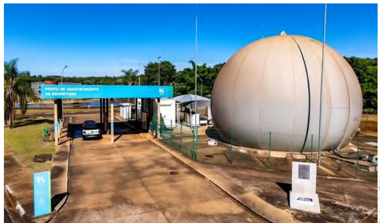
Central de tratamento de esgoto da Sabesp em Franca: produção de biogás com efluentes urbanos.
